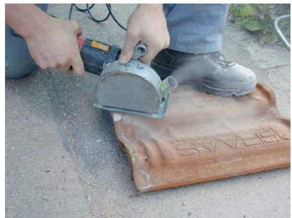
Aussparung für Dachhaken aus Ziegel herausklopfen bzw. ausschneiden
