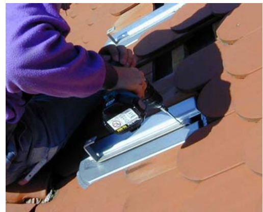
Befestigung eines Biberschwanzdachhakens
