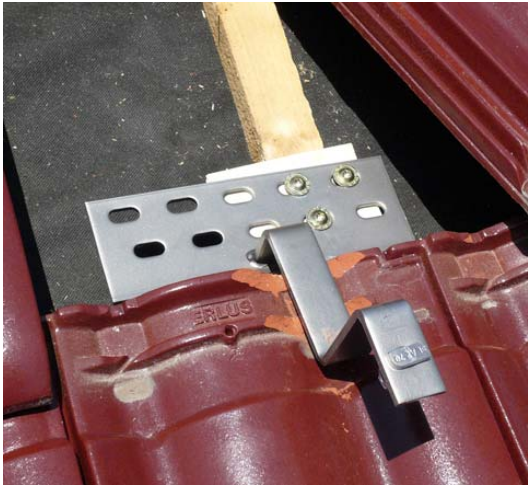
Gesetzter Dachhaken mit unterlegtem Ausgleichsholz zum Höhenausgleich
