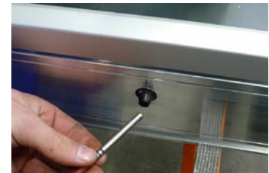
Abb.1: Kollektorfühlermontage
