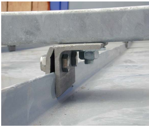
Montage auf Stehfalzblechdach
